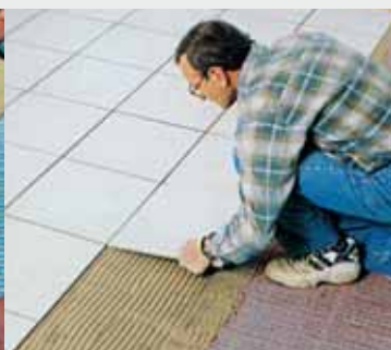
přilepit dlažbu a po ca 6 hodinách vyspárovat flexibilní spárovací hmotou ARDEX FL a po ca 1,5 hod je Vaše dlažba pochůzná
