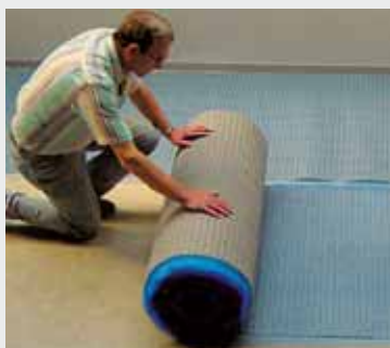
Stačí rozvinout na vyrovnaný podklad
