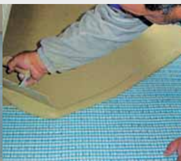
Rozmíchat a natáhnout lepidlo pro celoplošné lepení ARDEX FB 9L
